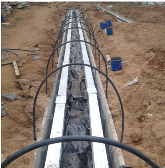
Рис 9. Участок прямой трассы смонтированного шинопровода с временными опорами для навешивания защитной пленки укрытия от осадков на время монтажа. На расстоянии видны использованные разовые емкости (голубого цвета) из под компаунда
