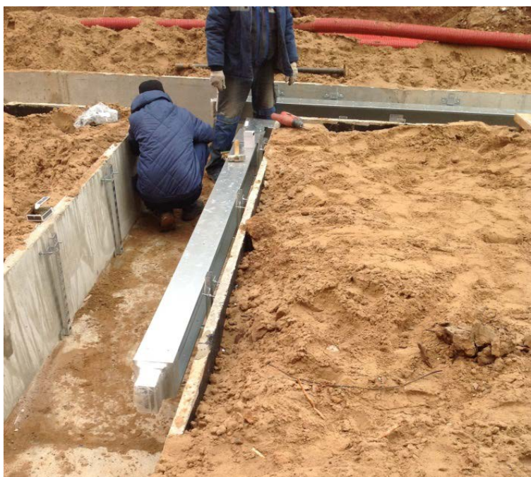
Рис. 8. Монтаж шинопровода с IP 68 в ЖБК-лотке на участке поворота трассы в 90 градусов
