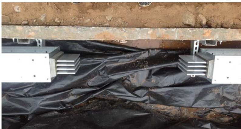
Рис. 4. Подготовка шинпровода к стыкованию укладкой на опорные конструкции (полки и стойки) из оцинкованной стали. На дне ЖБК-лотка – снятая пленка для укрытия от осадков
