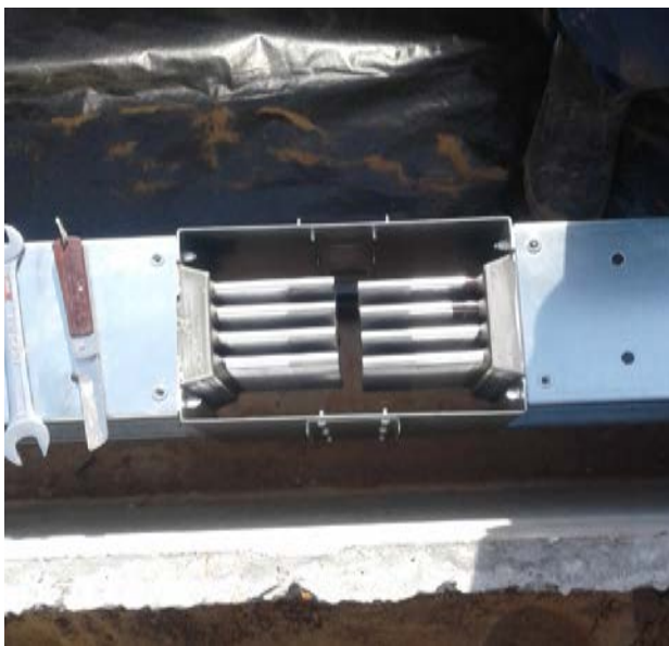
Рис. 5. Монтаж корпуса стыковочного элемента шинопровода для заливки компаундом
