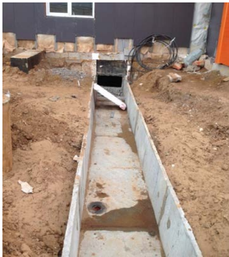
Рис. 3. Установка ЖБК-лотка для ввода коммуникаций электроэнергетики в здание. На уклонах трассы (до 0,5 % по вертикали) смонтированы отверстия для стока конденсата в приемок для сборки влаги
