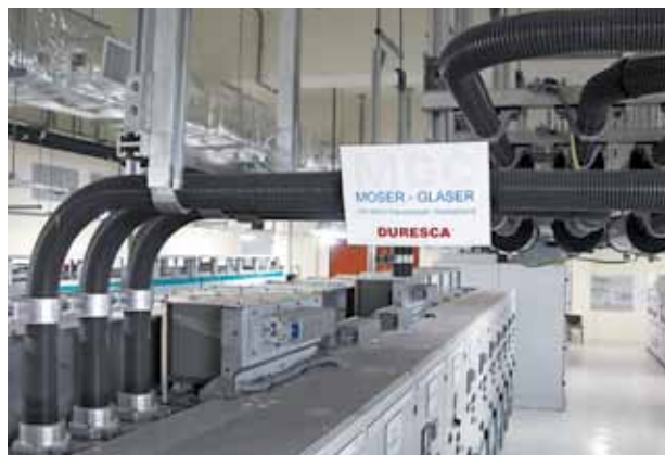
DURESCA 12 кВ 2500 А. Подключение к КРУЭ
