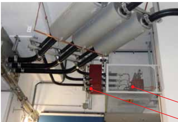
Подключение измерительных трансформаторов
