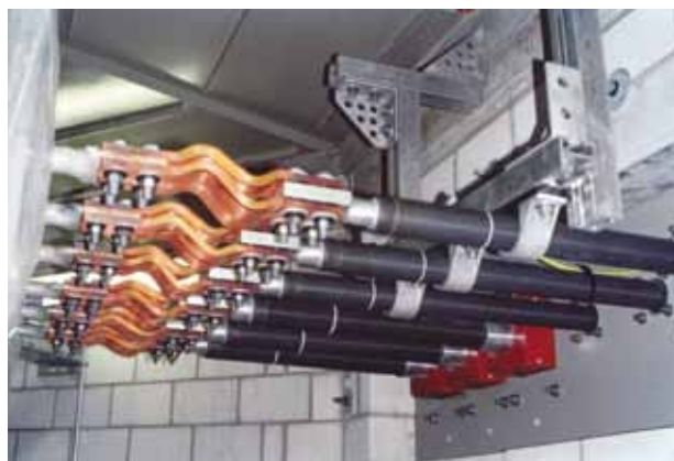
DURESCA 7,2 кВ 1600 А Подключение токопровода шинными компенсаторами
