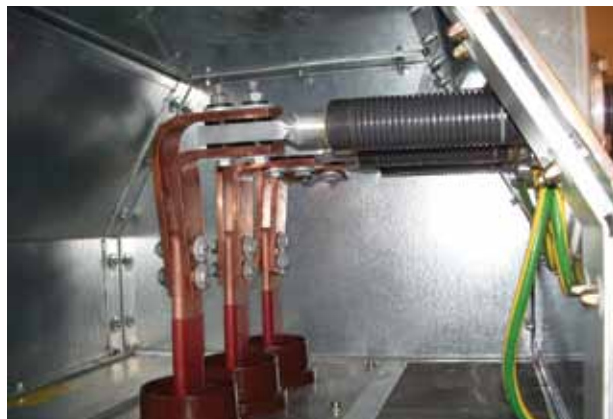
DURESCA 7,2 кВ 3150 А Узел подключения к выводам ячейки с воздушной изоляцией
